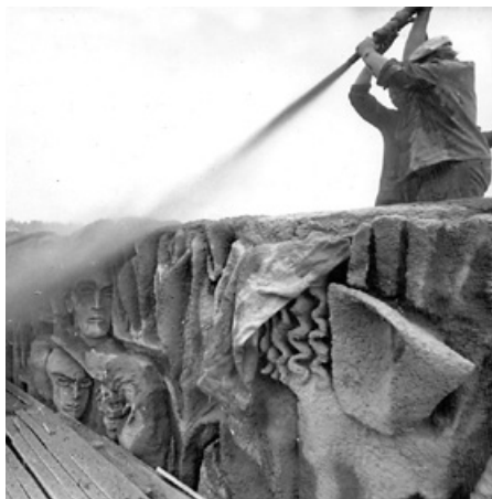
Владимир Мельниченко со «стekom», работающим под давлением шесть атмосфер
